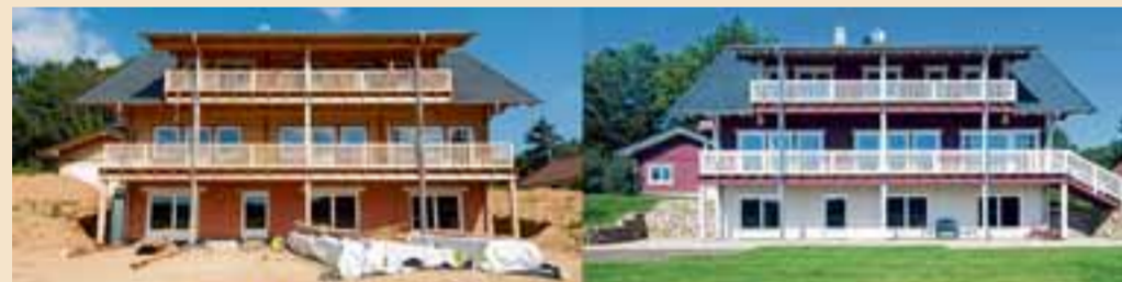
Mit einem Holzhaus aus Finnland wollte sich das Ehepaar Friedel seinen Hausraum verwirklichen. Doch durch unsachgemäße Abdichtung wäre es fast zum Altraum geworden. Die ISOTEC-Profis konnten helfen und retten. Foto: ISOTEC/www.fototeam-doelzer.de
